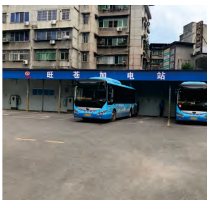
一体式直流桩---公交车充电站
