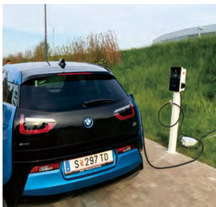
三相交流桩---罗马尼亚公共充电站
